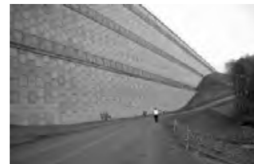
Hình 1. Tường chắn đất đường bộ
