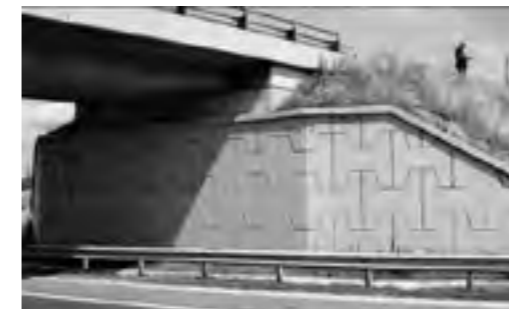
Hình 2. Tường chắn đất ở móng trụ cầu
