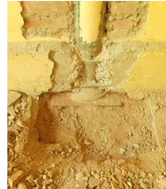
Hình 3. 12 Khảo sát phá dỡ để phát lộ cột sắt bị xây kín trong quá trình sử dụng
