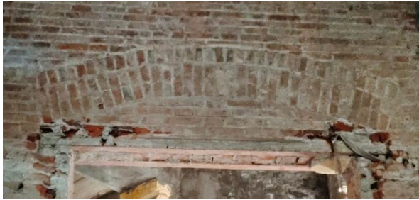
Hình 1. 23 Chi tiết vòm cuốn gạch công trình Nhà B Bộ giao thông vận tải.
