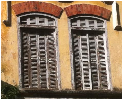
Hình 3. 13: Cửa chớp nguyên gốc ở công trình VAXUCO
