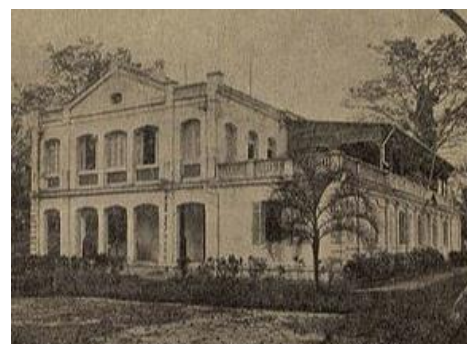
Hình 1. 17 Nhà công sứ- Kiến trúc điển hình khu nhượng địa
