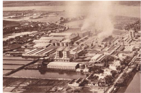
Hình 2. 28 Nhà máy xi măng tại Hải phòng năm 1936 [Les Entreprises coloniales françaises]
