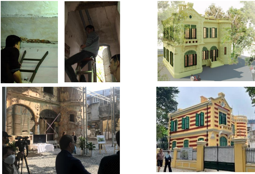
Hình 2.55 Quy trình bảo tồn biệt thự 49 Trần Hưng Đạo (từ trái qua phải, từ trên xuống dưới): 1/Đo vẽ khảo sát → 2/Chẩn đoán → 3/Đề xuất phương án → 4/Lấy ý kiến cộng đồng → 5/ Kết quả
