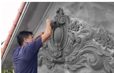
Hình 2. 42 Đắp phù điêu trang trí công trình. [internet]
