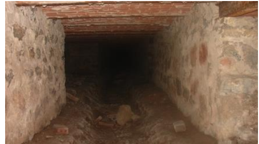
Hình 1. 24 Nền móng ở công trình Nhà B Bộ giao thông vận tải.
