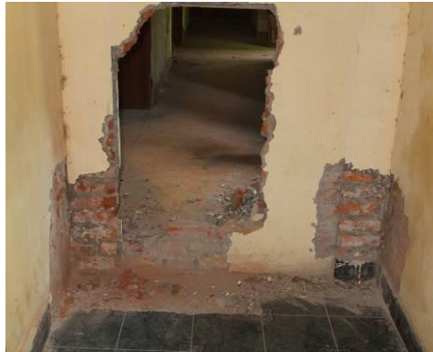
Hình 3. 11 Khảo sát phá dỡ làm rõ phần cấu trúc tường gạch mới bổ sung vào cấu trúc nguyên gốc
