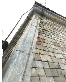
Hình 2. 13 Hình 2. 14 Cấu kiện mái với các vì liệu đá xẻ, kẽm úp bờ nóc, hệ vì kèo thép hình liên kết đinh tán
