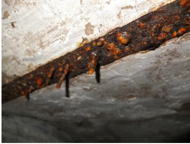
Hình 2. 35. Hiện tượng oxy hóa đậm thép I rất phổ biến ở tầng hầm của các công trình KTTĐP
