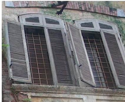
Hình 3. 14: Cửa chớp được thay thế ở công trình VAXUCO
