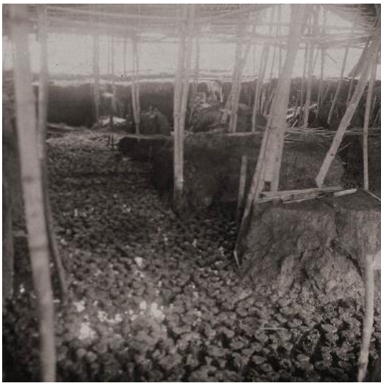
Hình 2. 8, Hình 2. 9 Hình ảnh quá trình và sau khi hoàn thành hệ cọc tre gia cố nền của một biệt thự TĐP tại Miền Bắc VN
