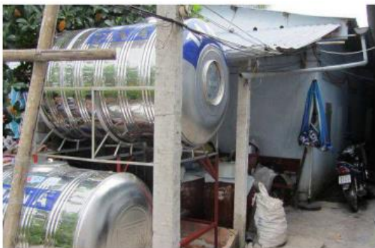
Hình 1.11 Thí điểm tái sử dụng nước mưa quy mô hộ gia đình tại Quận Cái Răng và quy mô công trình tại Khoa Môi trường và Tài nguyên thiên nhiên – Trường Đại học Cần Thơ
