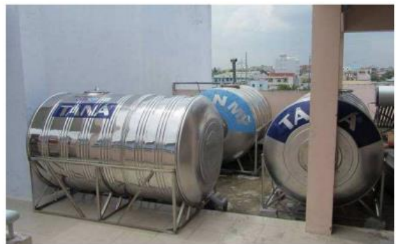
Hình 1.11 Thí điểm tái sử dụng nước mưa quy mô hộ gia đình tại Quận Cái Răng và quy mô công trình tại Khoa Môi trường và Tài nguyên thiên nhiên – Trường Đại học Cần Thơ
