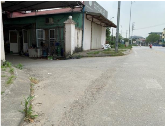
Hình 1.8. Chênh lệch cốt nền giữa khu dân cư hiện hữu với khu đô thị mới
