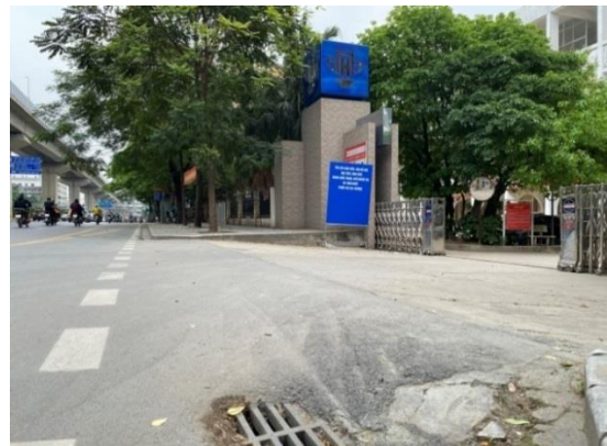
Hình 1.13. Chênh lệch cốt nền giữa trục đường Quốc lộ 6 và trường Đại học Kiến trúc Hà Nội
