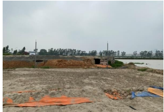
Hình 1.15. Thực trạng san nền tại Khu đô thị mới Thanh Hà
