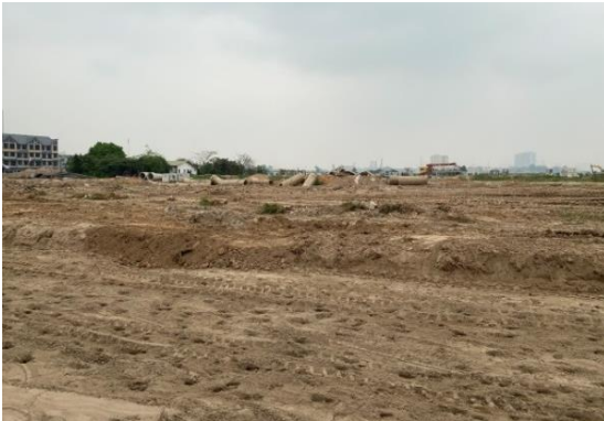
Hình 1.14. Thực trạng san nền tại Khu đô thị mới Kim Chung - Di Trạch
