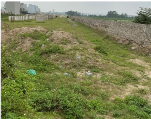
Hình 1.12. Hoàn trả vệt tụ thủy bằng hệ thống cống hộp không đảm bảo kích thước
