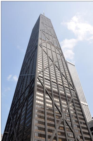
Hình PL3-5: Minh họa về ảnh hưởng của hệ kết cấu tới kiến trúc.
