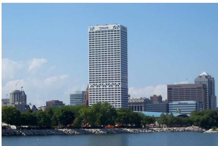
Hình PL3-6: Minh họa về ảnh hưởng của hệ gánh outrigger tới kiến trúc.
