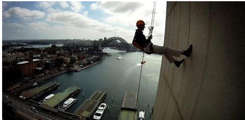
Hình 2-20: Xây dựng tòa nhà AMP ở Sydney, Úc
