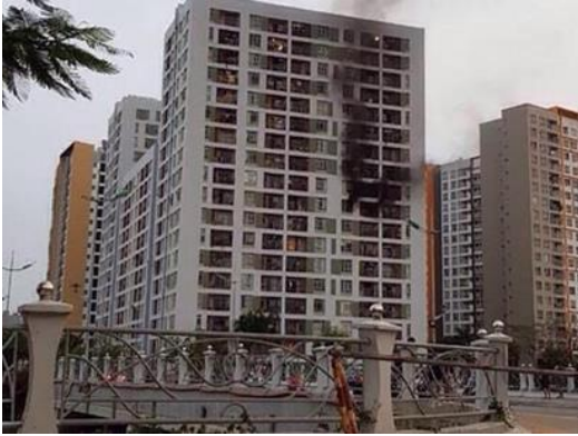
Hình 1-1: Cháy tòa nhà Park Spring, Quận 2, T.P. Hồ Chí Minh
