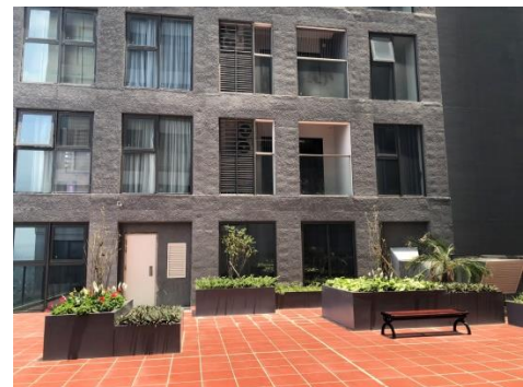
TLN 2 tòa nhà được mở trực tiếp ra sân vườn là nóc khối cầu trên cao kết nối 2 tòa nhà
