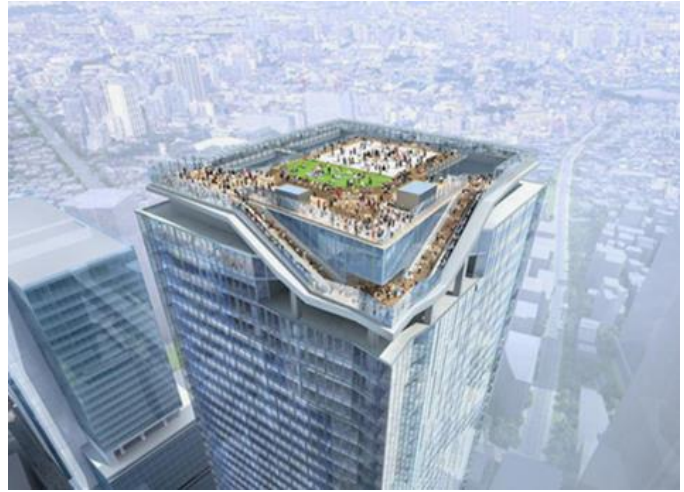
Hình 3-20: Bố trí vườn trên mái và không gian công cộng. Tòa nhà chọc trời ở Quận Shibuya, Tokyo, Nhật Bản
